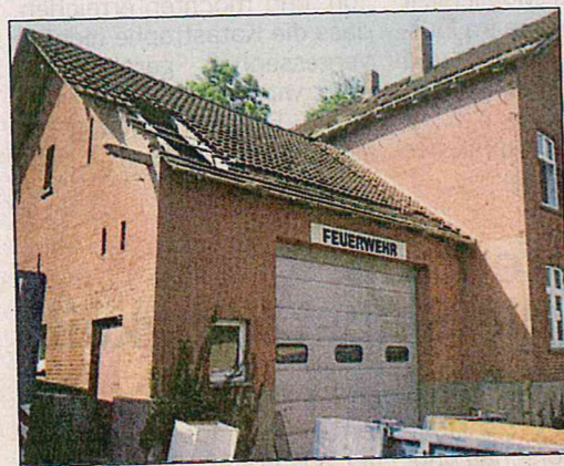
Vergangene Zeiten: Das alte Feuerwehrhaus in Stemmen wurde abgerissen.
