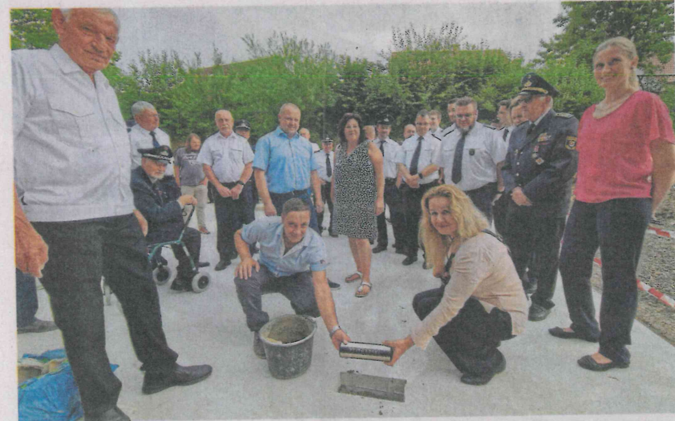
Eva Hermann und Nicolai Stoll vom Bauamt der Gemeinde Kalletal setzen die Zeitkapsel ins Fundament des neuen Feuerwehrgerätehauses in Talle, während unter anderem dahinter Uwe Kordfunke (links) aus der Ehrenamtsabteilung der Feuerwehr, Bürgermeister Mario Hecker (hinter Nicolai Stoll), daneben Fachbereichsleiterin Ordnung und Soziales Andrea Batzer sowie Architektin Wera Binder (rechts) stehen.
