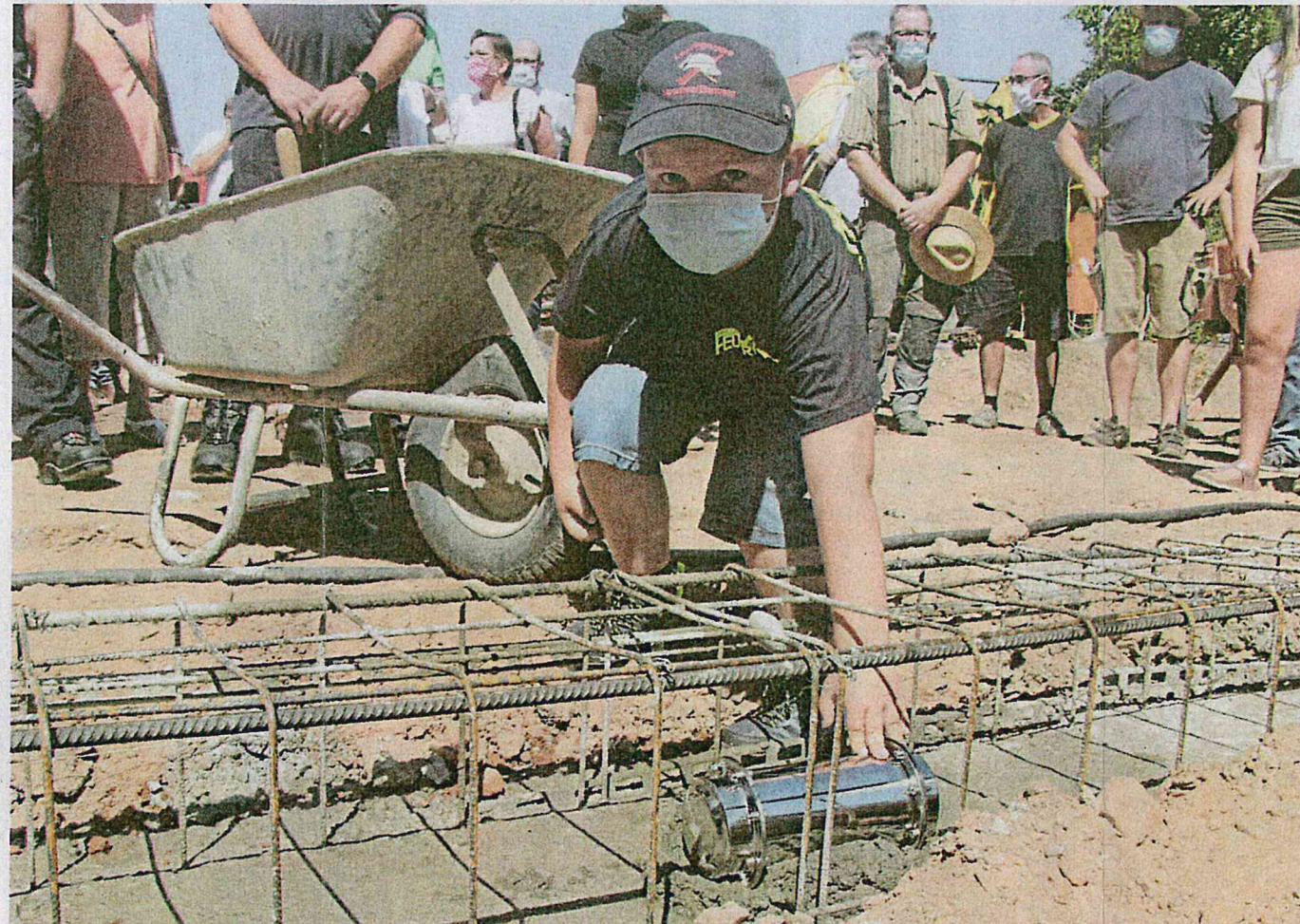
Der siebenjährige Marlon Mannetter, Mitglied der Kinderfeuerwehr, hat die Zeitkapsel in das Fundament des neuen Multifunktionshauses eingelegt. Hier finden bald Feuerwehr, AWO und Vereine Platz unter einem Dach.
