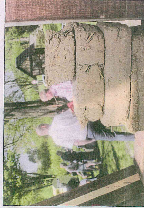
Mit solchen handgefertigten Lehmziegeln sollen die Gefache nach den Sommerferien ausgefüllt werden.
