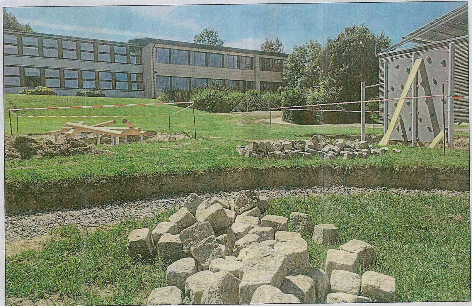
Bauarbeiten an der Grundschule Bavenhausen: Hier wie auch in Langenholzhausen werden Laufbahn und Sprunggruben erneuert.
